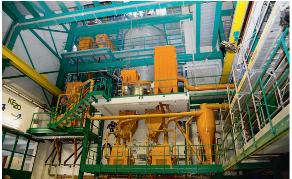
Die Aufbereitungsanlage für Feinschlacke (0,7–5 mm) und Feinstschlacke (0,2–0,7 mm) in der KVA Hinwil. Foto: R. Strässle
